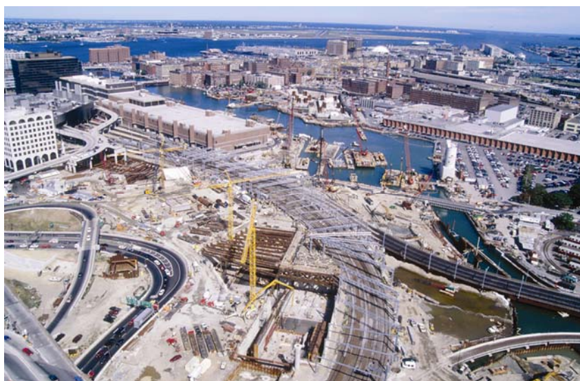
Gradilište najvećega tunela u Bostonu
